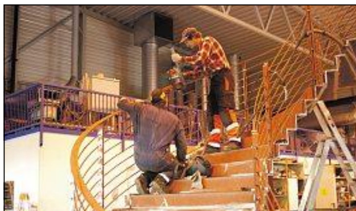
GELENDER: Håndløperen skal på plass, og den skal være både bøyd og vridd. At trappa mangler vanger ("sidevegger"), gjør trappa luftig.
